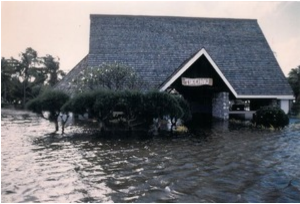
Aéroport de Tikehau (Tuamotu), submergé par la forte houle de 1996. Fourni par l'auteur
